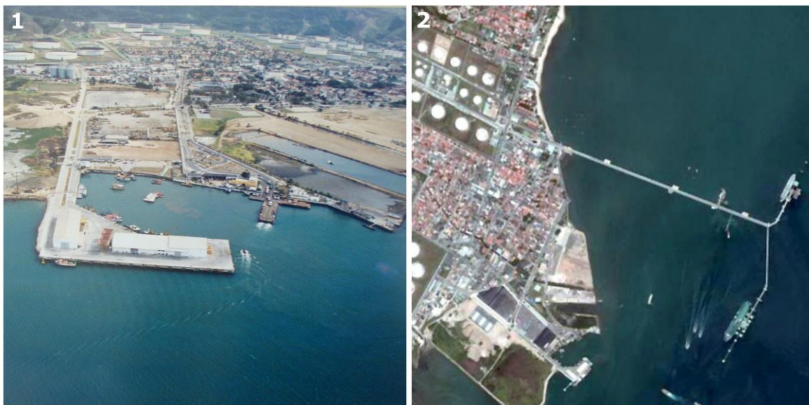
Figura 11: Instalações do Porto de São Sebastião na década de 1990
