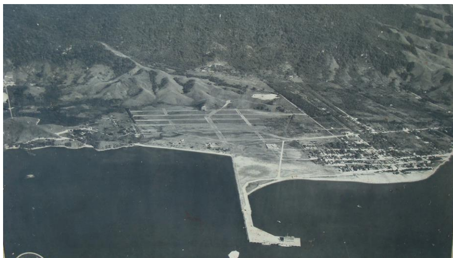
Figura 9: Vista aérea de frente para a região do porto na década de 1950
