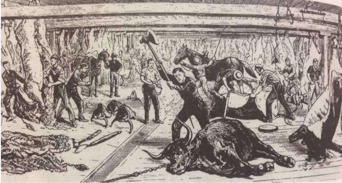
Figura 22 – abate em sistema de instalação fixa
