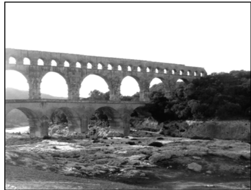
Figura 260: Pont du Gare, Remoulins, França.
