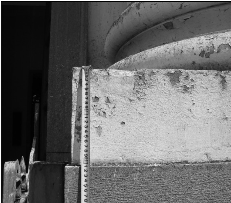
Figura 27: Medida métrica do plinto da base da coluna central da Ordem Jônica da fachada Catedral Nossa Senhora da Conceição de Campinas.
