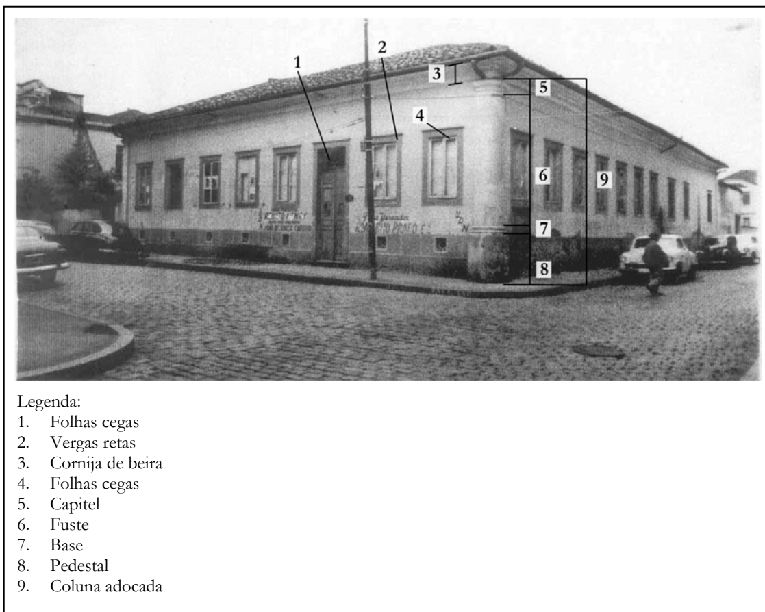
Figura 183: Residência de Floriano de Camargo Pentead. Posterior residência de seu genro, barão de Itatiba.
