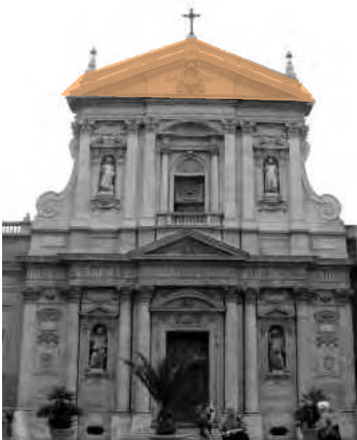
Figura 303 C: Frontão na largura da nave central.
