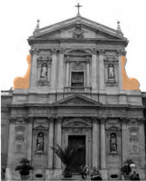
Figura 303 A: Volutas para fechamento do telhado da nave lateral.
