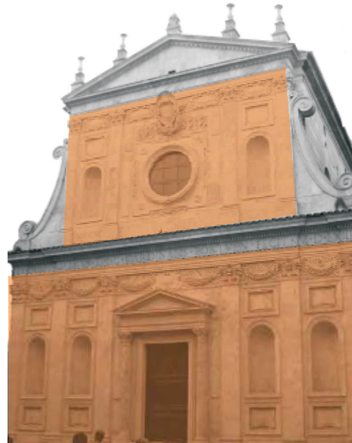
Figura 301 D: Andar Superior: Largura correspondente à nave central. Andar Térreo: Largura correspondente à extensão do edifício.
