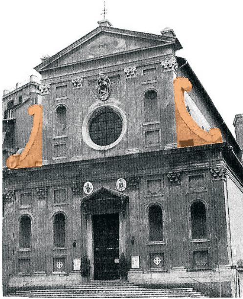
Figura 300 A: Volutas para fechamento do telhado da nave lateral.
