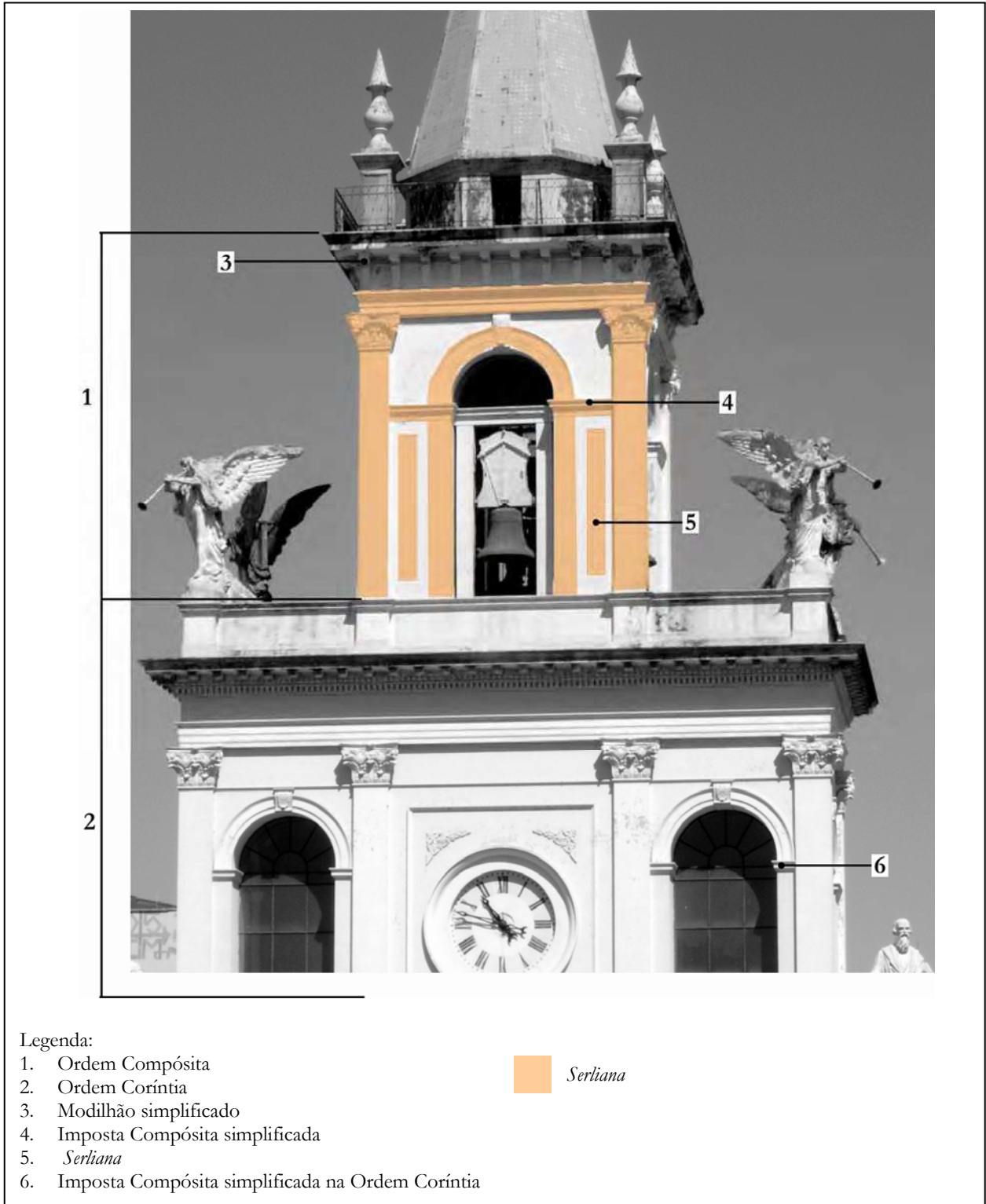
Figura 172: Elementos arquitetônicos e ornamentais supostamente realizados por Ramos de Azevedo, na Catedral Nossa Senhora da Conceição de Campinas.
