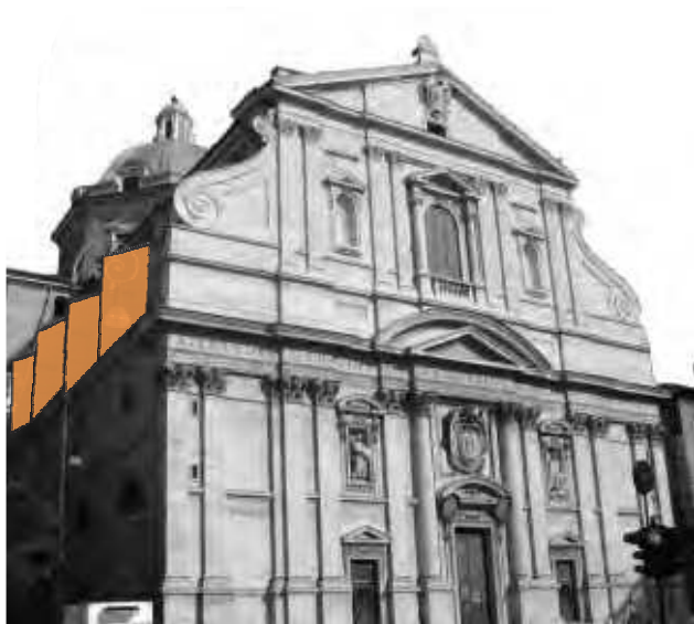
Figura 297 C: Detalhamento dos contrafortes escondidos pela voluta da fachada.
