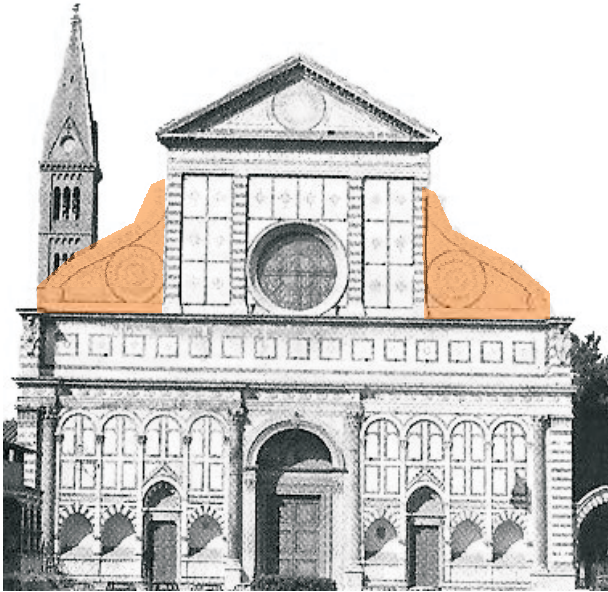
Figura 299 A: Volutas para fechamento do telhado da nave lateral.
