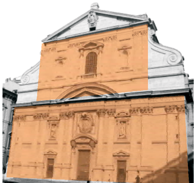
Figura 297 D: Andar Superior: Largura do edifício corresponde à nave central. Andar Térreo: Largura corresponde a toda extensão do edifício.
