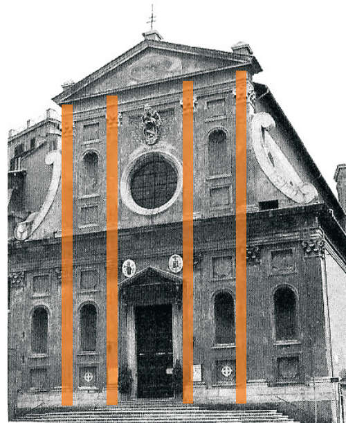
Figura 300 B: Pilastras alinhadas no térreo e no superior. Foto:
