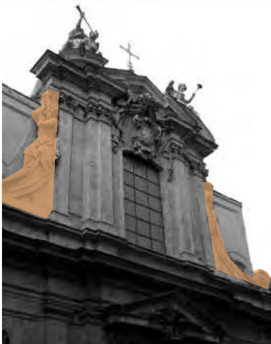
Figura 304 A: Volutas para fechamento do telhado da nave lateral.
