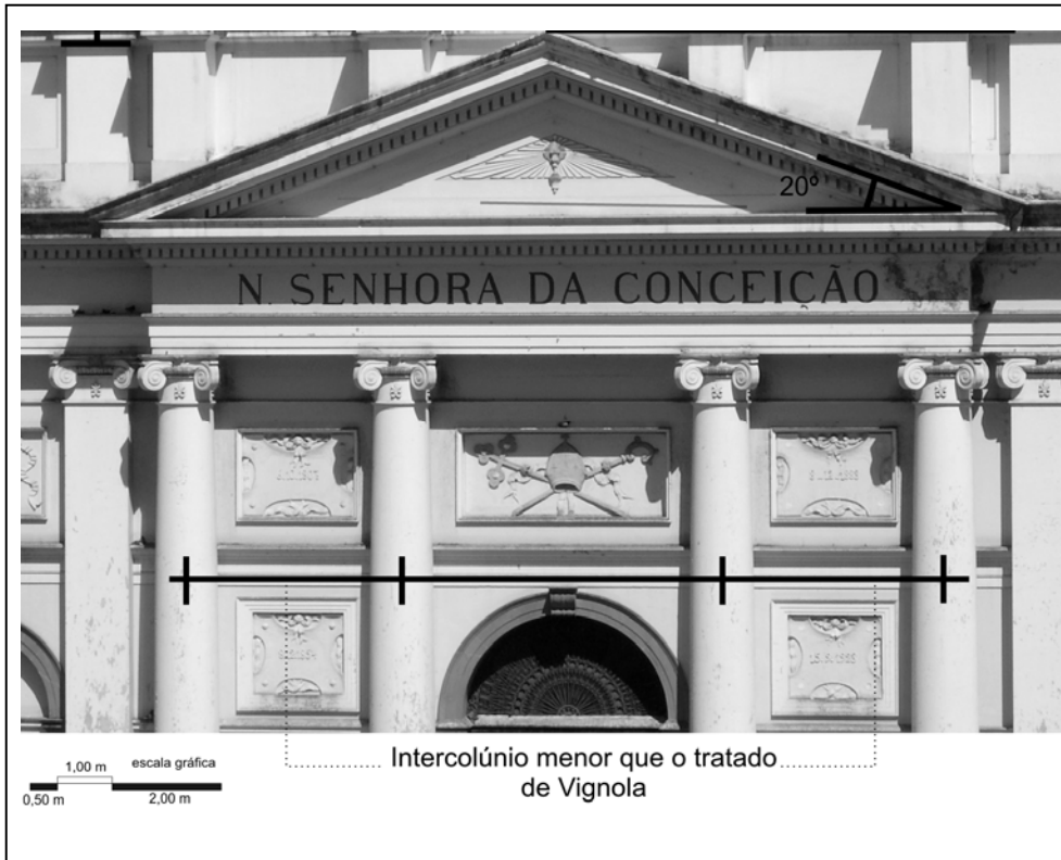
Figura 39: Frontão da Ordem Jônica da fachada da Catedral Nossa Senhora da Conceição de Campinas.
