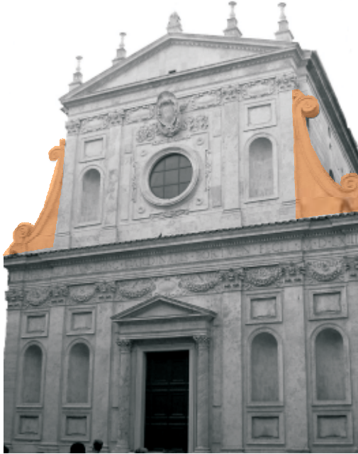
Figura 301 A: Volutas para fechamento do telhado da nave lateral.
