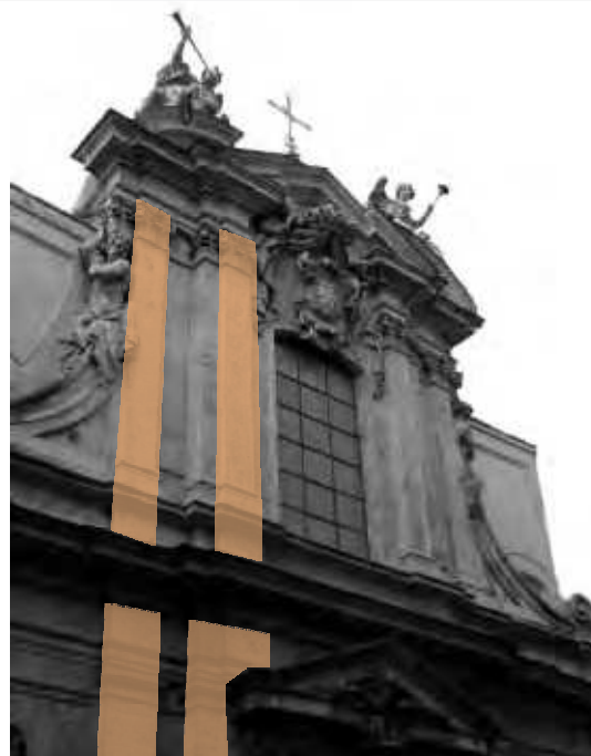
Figura 304 B: Pilastras alinhadas no térreo e no superior.
