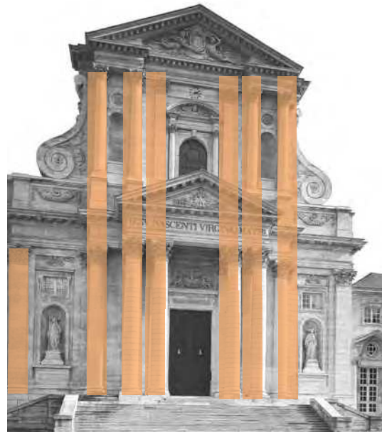
Figura 305 B: Pilastras alinhadas no térreo e no superior.
