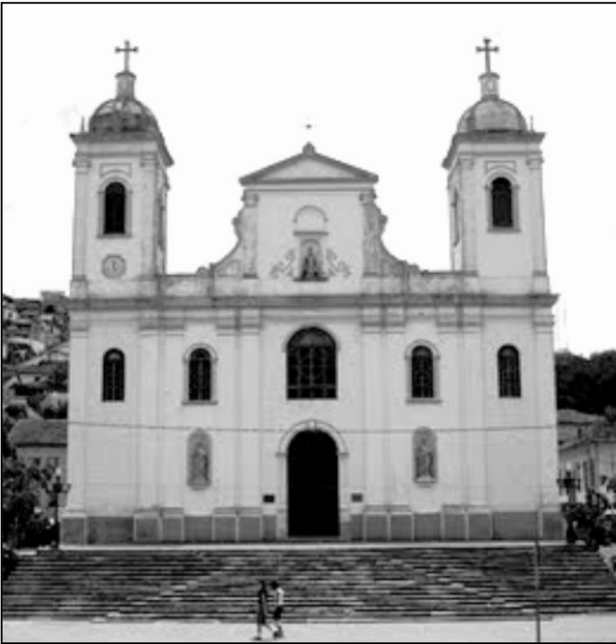
Figura 166: Fachada da Igreja Matriz Luiz de Tolosa, São Luiz do Paraitinga – SP.
