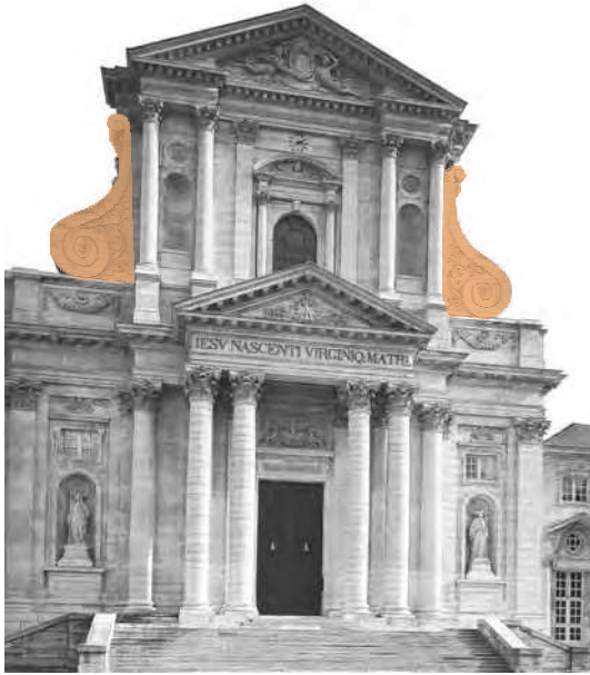
Figura 305 A: Volutas para fechamento do telhado da nave lateral.
