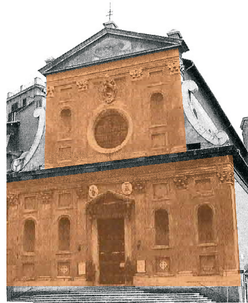
Figura 300 D: Andar Superior: Largura correspondente à nave central. Andar Térreo: Largura correspondente à extensão do edifício.
