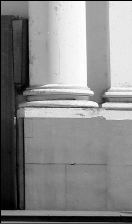
Figura 87: Pedestal e base da Ordem Jônica, fachada da Catedral Nossa Senhora da Conceição de Campinas.
