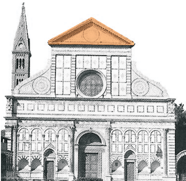
Figura 299 C: Frontão na largura da nave central.
