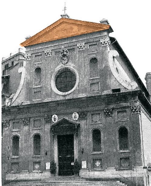
Figura 300 C: Frontão na largura da nave central. .
