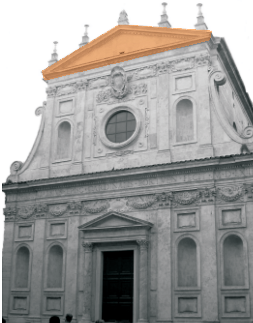
Figura 301 C: Frontão na largura da nave central.
