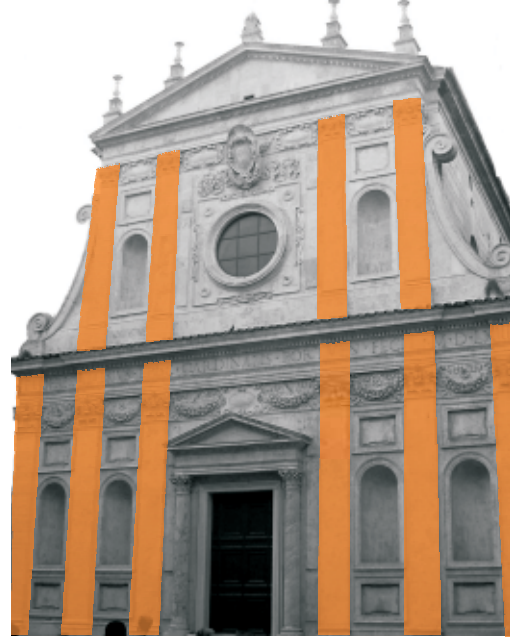
Figura 301 B: Pilastras alinhadas no térreo e no superior.
