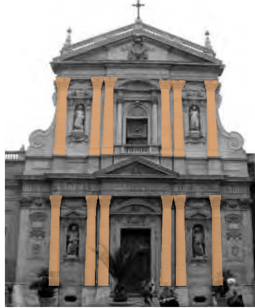
Figura 303 B: Pilastras alinhadas no térreo e no superior
