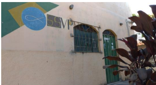
FIGURA 72 – Casa que sediava a Associação de Moradores do bairro Veneza, em Ribeirão das Neves
