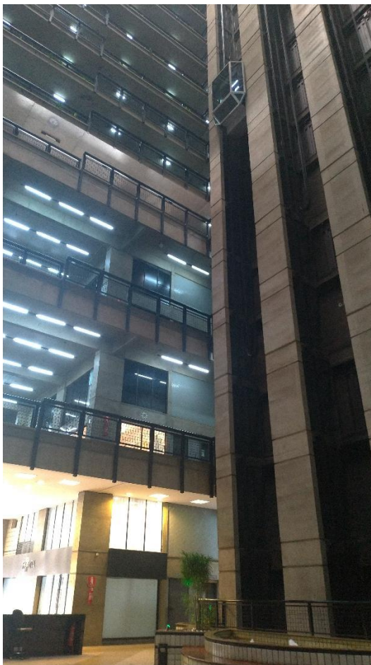
FIGURA 61 – Interior do Edifício Mondrian, no bairro Barro Preto, em Belo Horizonte, Com destaque para os elevadores panorâmicos e os seus vários pavimentos
