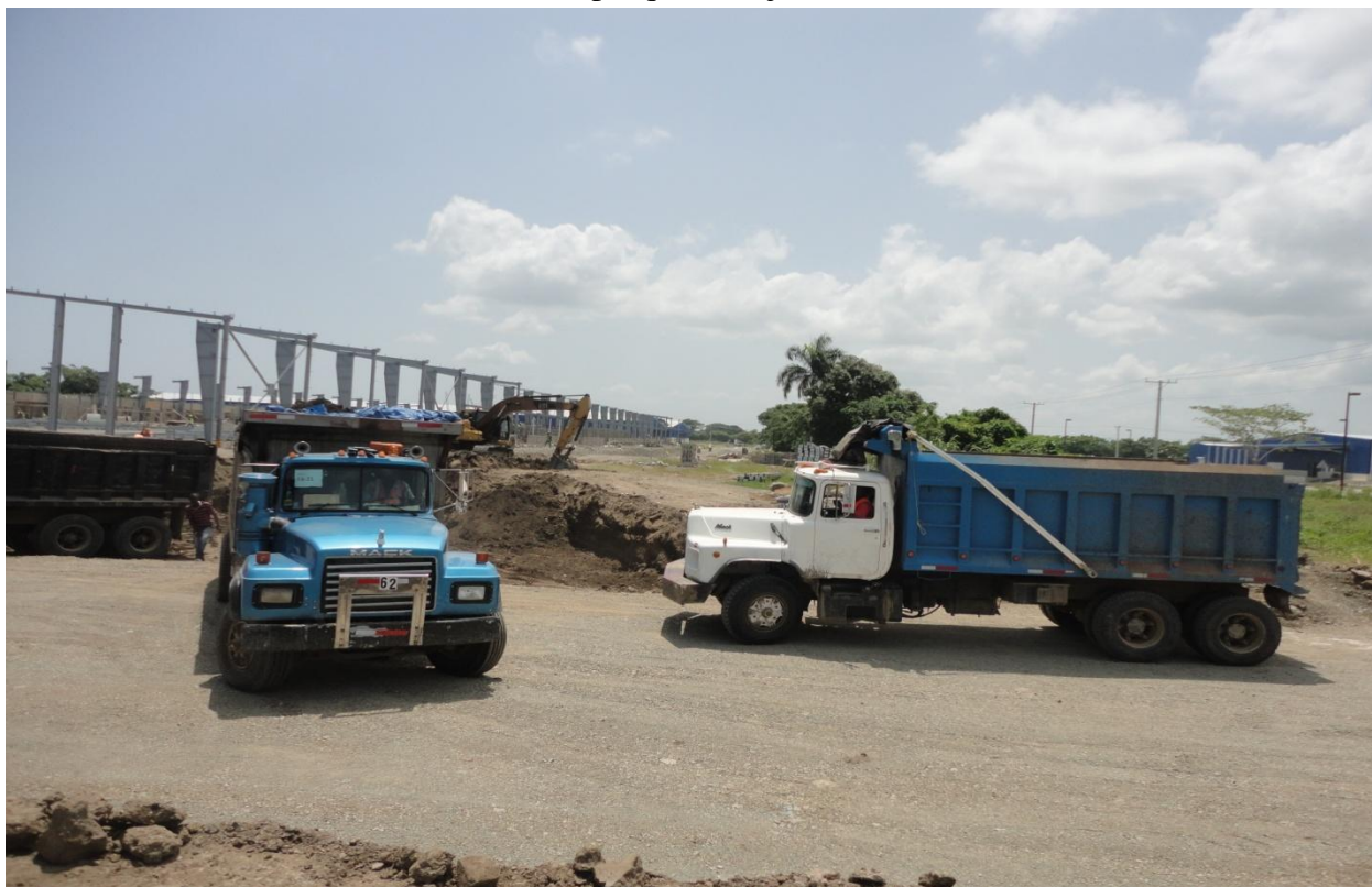
Canteiro de obras dentro do PIC. Foto do pesquisador julho de 2013.
