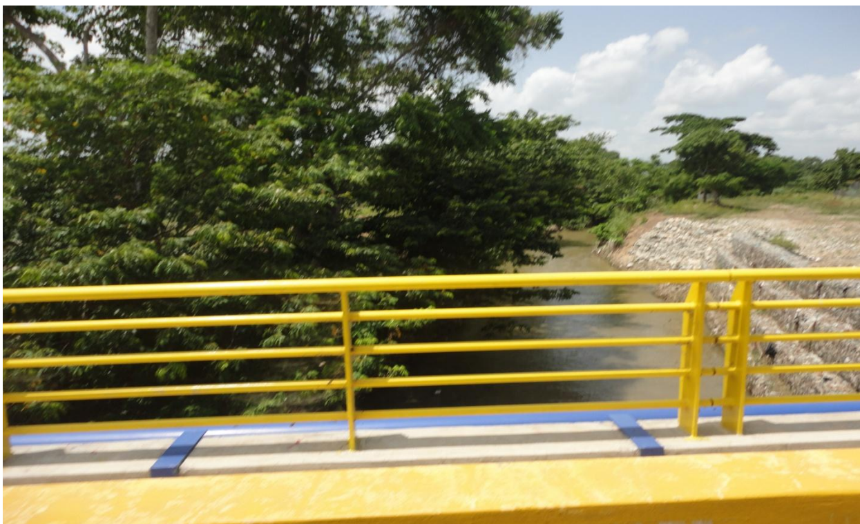
Ponte em cima de um dos dois rios de Caracol que atravessam o PIC. Foto do pesquisador julho de 2013.
