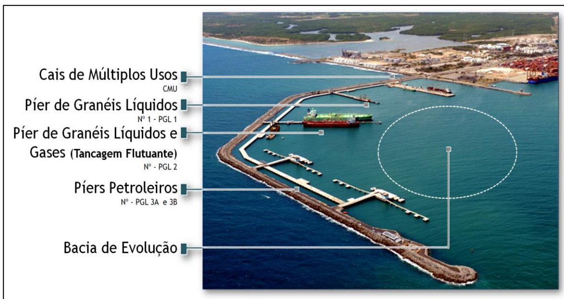
Figura 3.6 - Porto externo. Granéis líquidos e gases. Porto de Suape, 2014.
