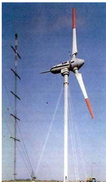
Aerogerador de duas lâminas, Growian. Fonte: https://commons.wikimedia.org
