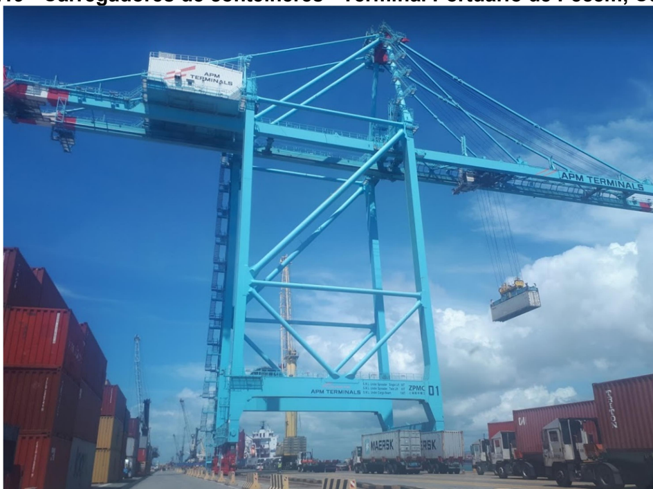
Figura 3.19 - Carregadores de contêineres - Terminal Portuário de Pecém, Ceará, 2019
