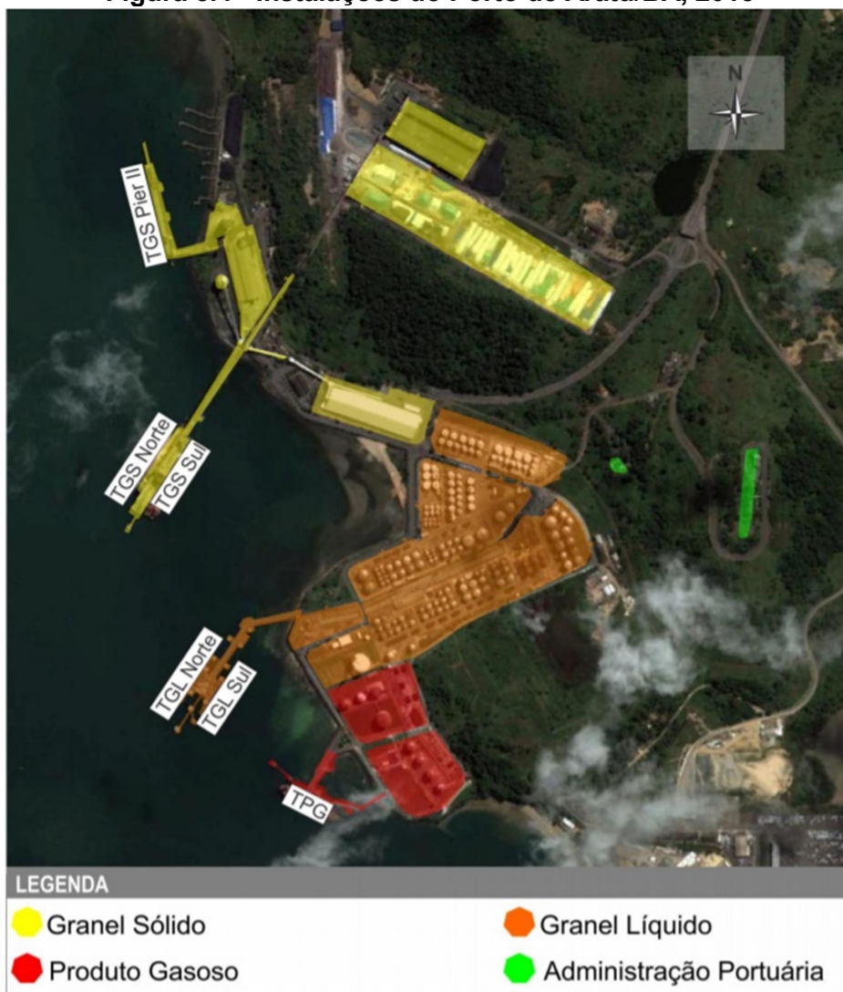
Figura 3.4 - Instalações do Porto de Aratu/BA, 2015
