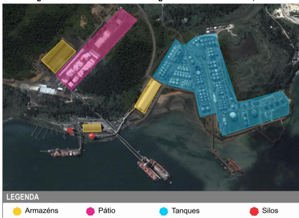
Figura 3.8 - Estruturas de armazenagem do Porto de Aratu/BA, 2015
