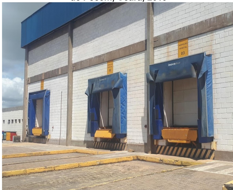
Figura 3.14 - Armazém 2 - acesso externo às câmaras frigoríficas - Terminal Portuário de Pecém, Ceará, 2019
