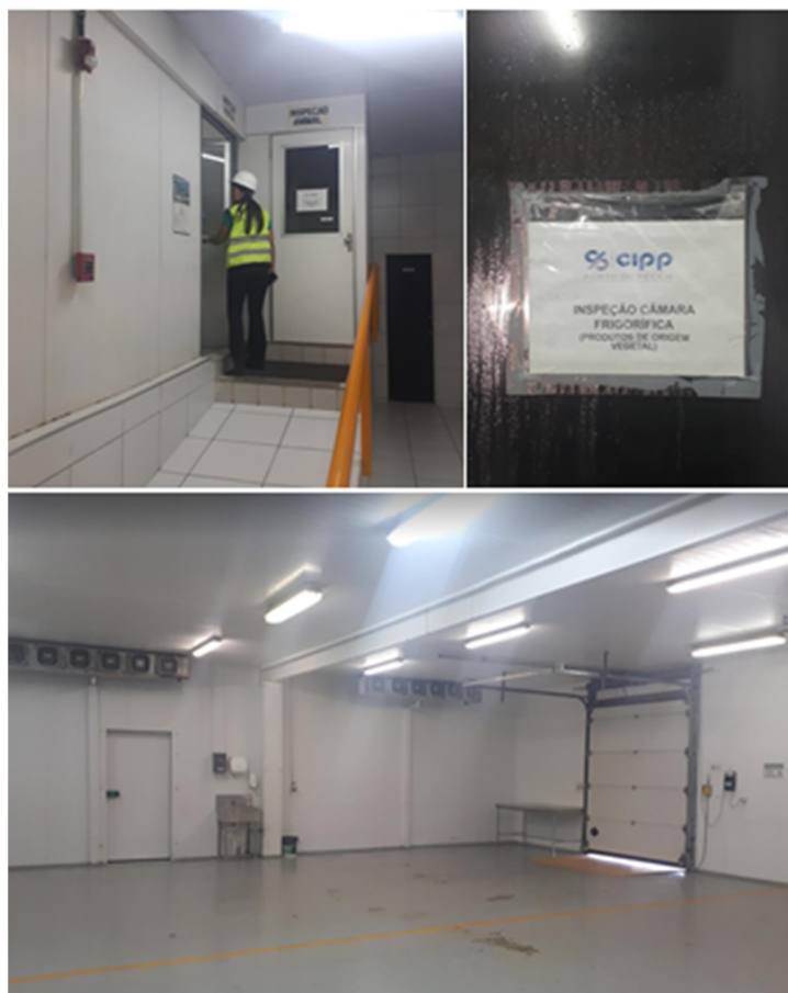
Figura 3.15 - Armazém 2 - acesso interno às câmaras frigoríficas - Terminal Portuário de Pecém, Ceará, 2019
