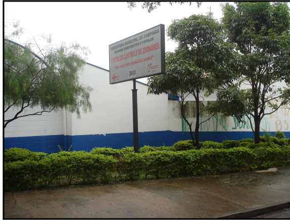
Figura 02 – Fachada do Centro de Controle de Zoonoses de Campinas.
