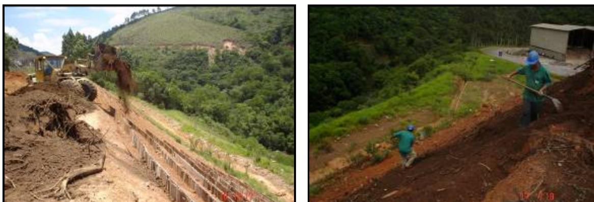
**Figura 2.** À esquerda, distribuição do *topsoil* com auxílio de maquinário. À direita, espalhamento manual do *topsoil* depositado no talude experimental de propriedade da Companhia de Cimento Ribeirão Grande (CCRG). Dezembro de 2004. Ribeirão Grande, SP.
