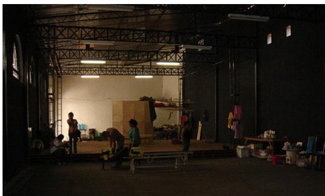
Figura 32 – (alto à esquerda) Integrantes do grupo Cuíra trabalham na adaptação do edifício para a criação do Teatro Cuíra
