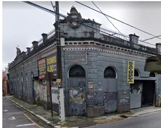
Figura 22 – Estacionamento que funciona no edifício que havia sido ocupado pelo grupo Cuíra
