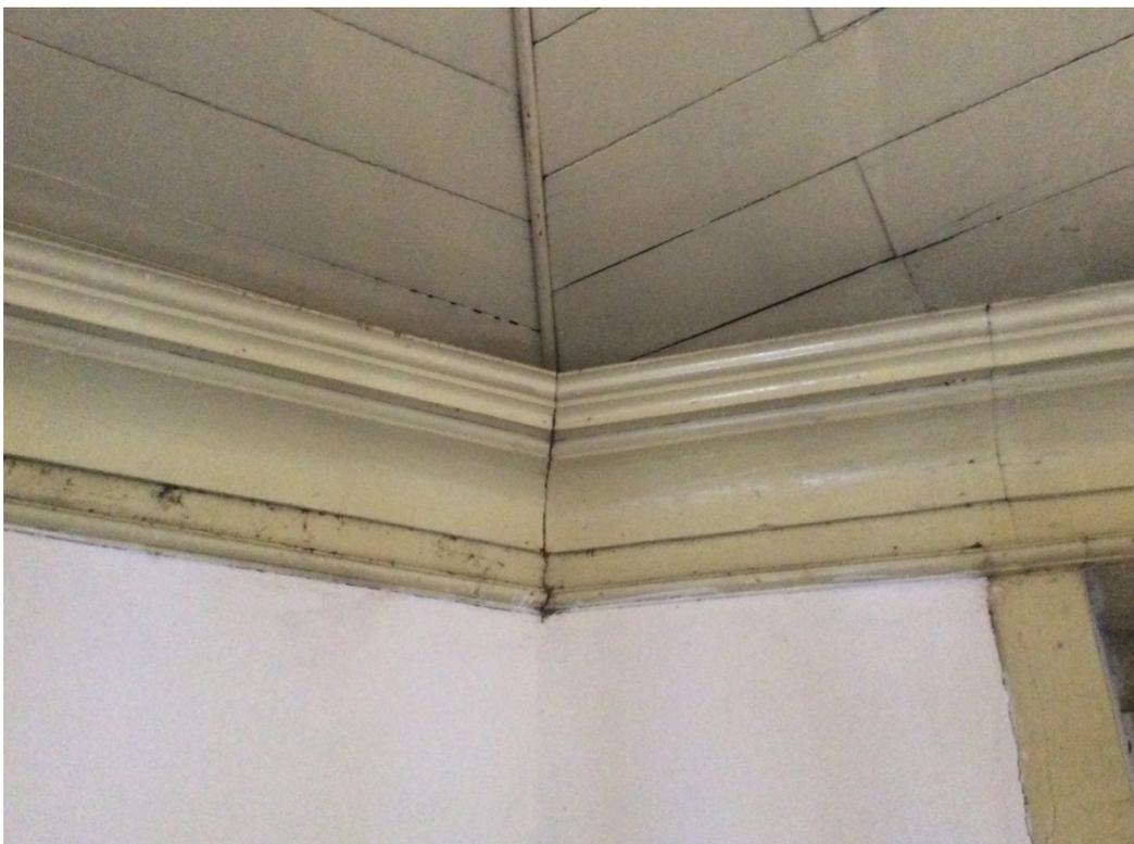
Foto 72 - Interior da Capela N. S. do Pilar-, Detalhe da sanca em madeira- Pavimento superior Estado atual, 18.05.2019. Fonte: Autora.
