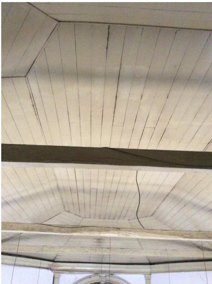
**Foto 41 - Interior da Capela N. S. do Pilar, Detalhe contra-traves e forro em “gamela”oitavada – Estado atual, 18.05.2019. Fonte: Autora**
