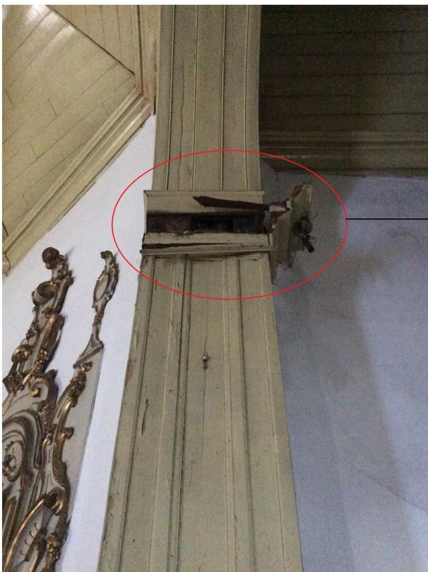
DT: Arco do cruzeiro com danos na talha; Apodrecimento da madeira; lâmpada e fiação elétrica exposta
