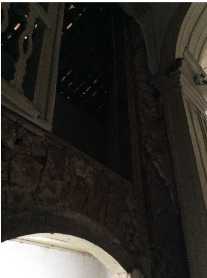
**Foto 52 - Interior da Capela N. S. do Pilar, Entrada lateral direita acesso Rua Bispo Rodvalho, detalhe falha na alvenaria do lado direito, taipa de mão à mostra— Estado atual, 18.05.2019. Fonte: Autora**
