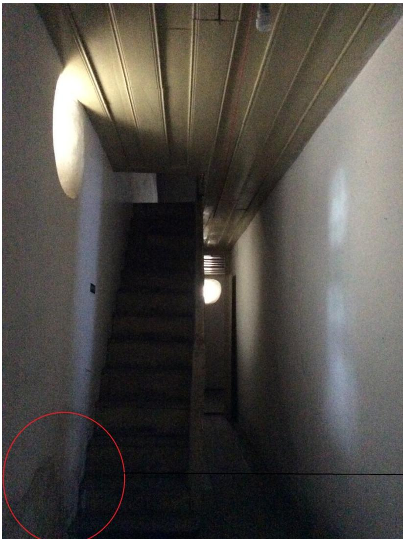
DT: Umidade na alvenaria de taipa; Descolamento de camada pictórica do revestimento interno da parede
