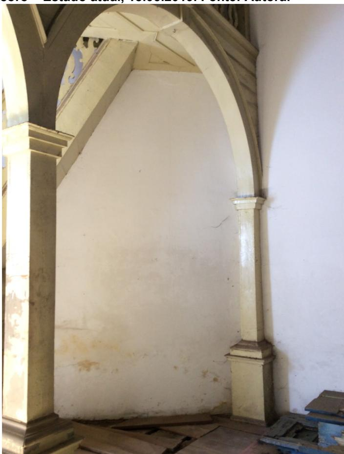
**Foto 44 - Interior da Capela N. S. do Pilar, Detalhe talha arcos sob o coro e danos no piso de madeira– Estado atual, 18.05.2019. Fonte: Autora**
