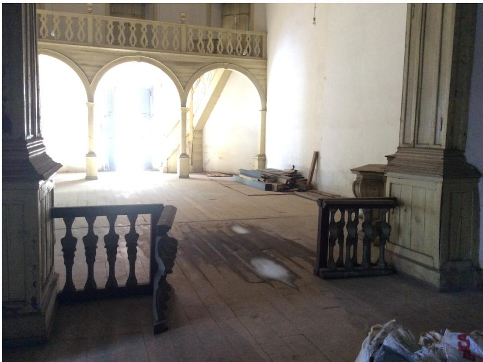
**Foto 40 - Interior da Capela N. S. do Pilar, Vista do Alta-mor – Detalhe umidade do piso em madeira– Estado atual, 18.05.2019. Fonte: Autora**
