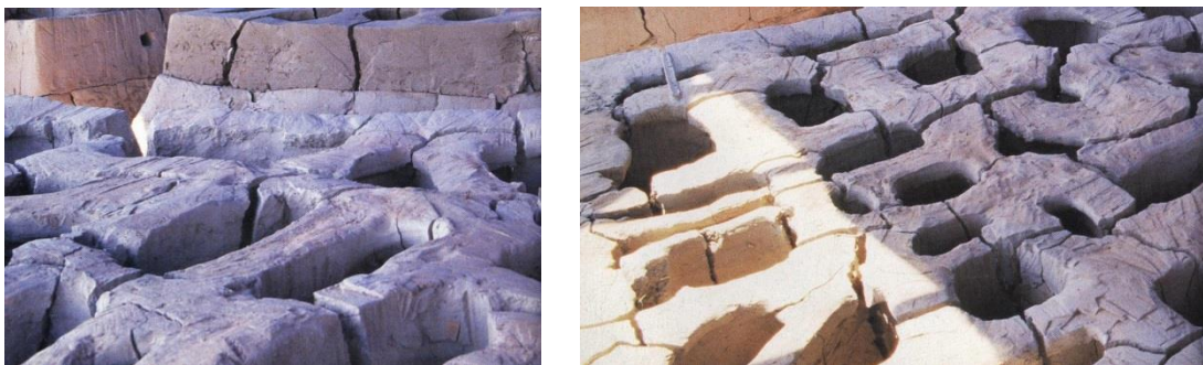
Figura 90 e 91 - Detalhe do Monumento das Flores com as rachaduras da secagem incorreta.
