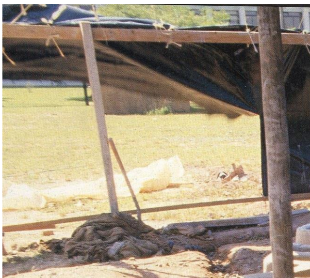
Figura 89 - Vista da proteção incorreta do monumento das Flores em São Paulo.
