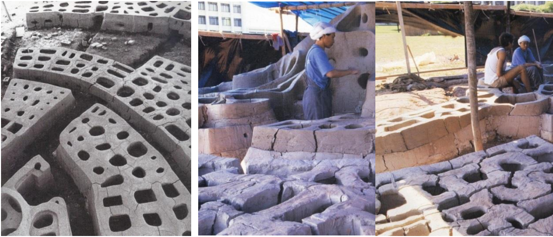
Figura 70 e 71 - Detalhes da construção da obra.
