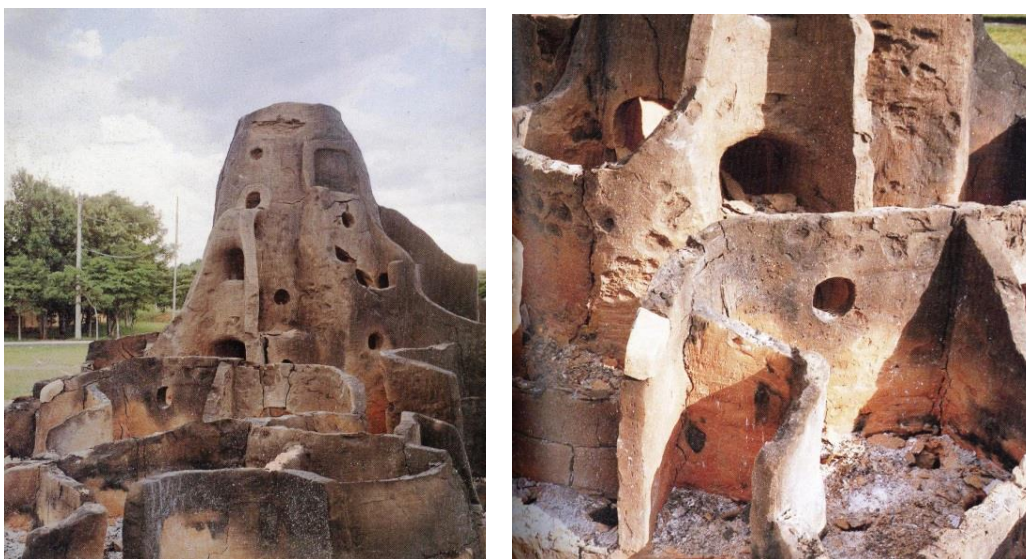
Figura 82 e 83 - Obra após a queima.
