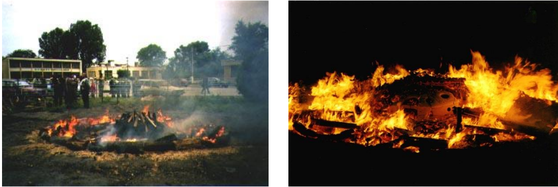
Figura 133 e 134 - Queima da obra.
