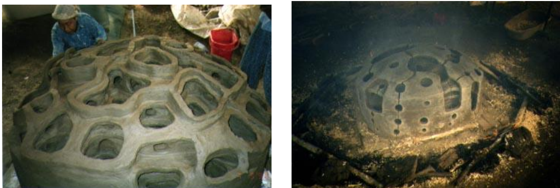
Figura 131 e 132 - Construção e queima.
