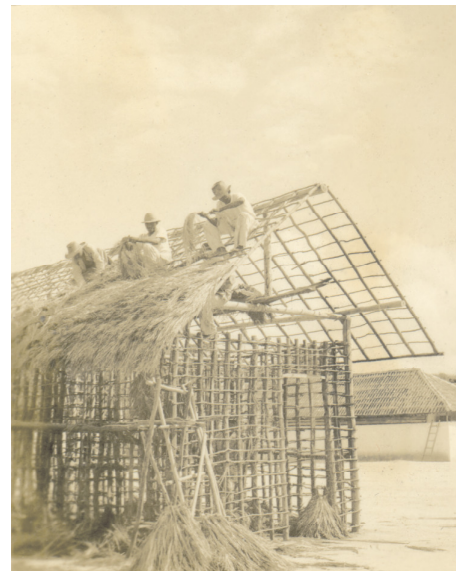
[Fig. 93] Futuros migrantes trabalhando na construção de alojamento no Pouso do Prado Fotografia Abafilm – MAUC, Fortaleza 519
