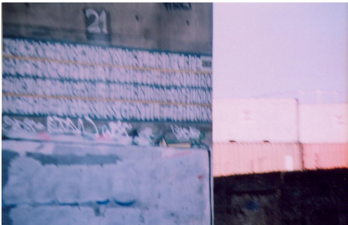
Figura (63) Pilastra 21. Foto da autora
