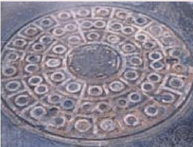
figura 561 -Tampa de ponto de inspeção
