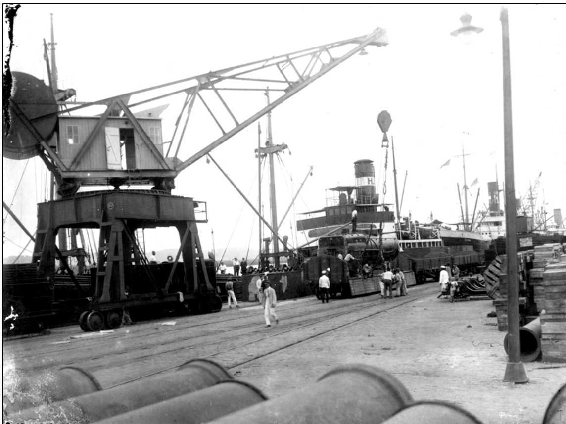
Figura 9 – Cais do porto c. 1929
