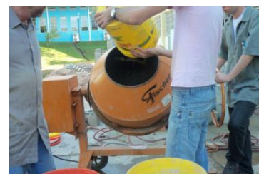
Figura 5.14: Introdução dos materiais na betoneira de eixo inclinado.
