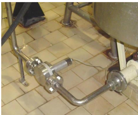
Figura 3.17 - Instalação do medidor de vazão METROVAL modelo OI - 2 SMRX/FS
