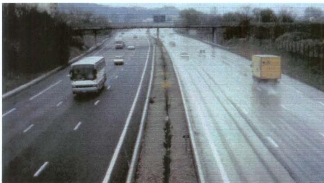
FIGUARA 21 – Comparação de Pavimentos Drenantes e Normais, cortesia de Colas France S.A., Kraton (2006).
