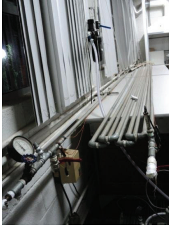
Figura 3.3: Tubulação de ferro galvanizado.
