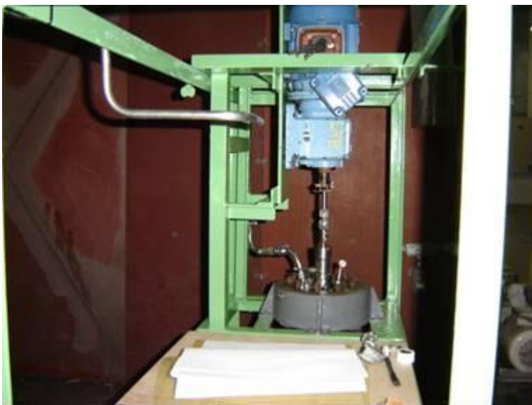
Figura 52. Montagem das conexões de interligação do sistema de vácuo.
