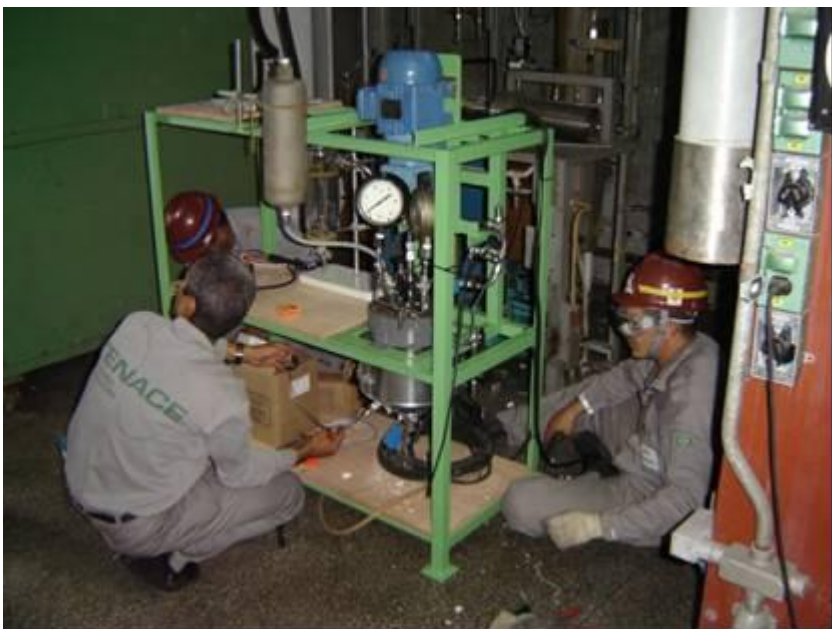
Figura 59. Interligação elétrica do sensor de temperatura e da resistência elétrica; Instalação do sistema de isolamento térmico do reator; Instalação do vacuômetro em paralelo com o manômetro.
