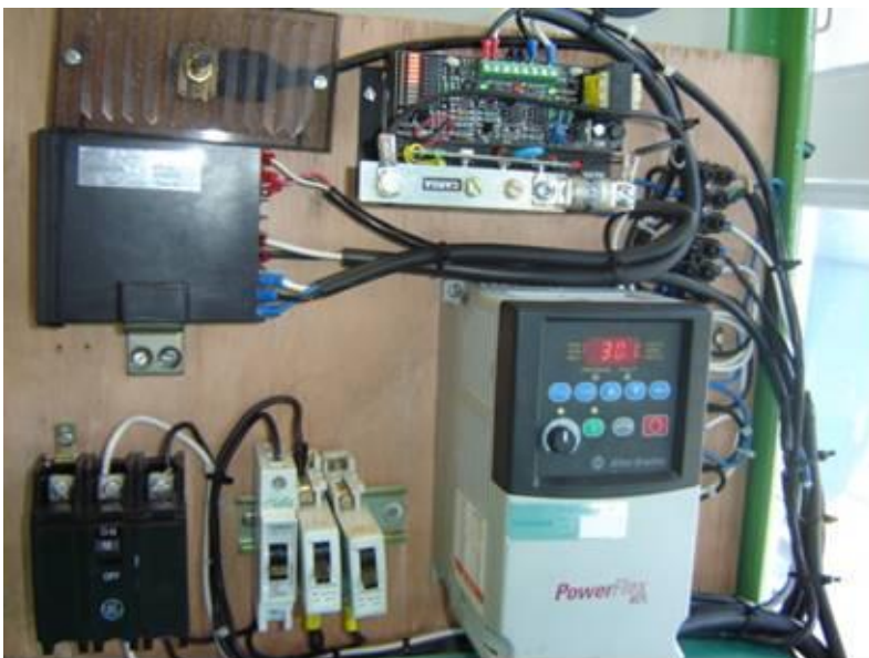
Figura 64. Montagem do painel elétrico de comando.
