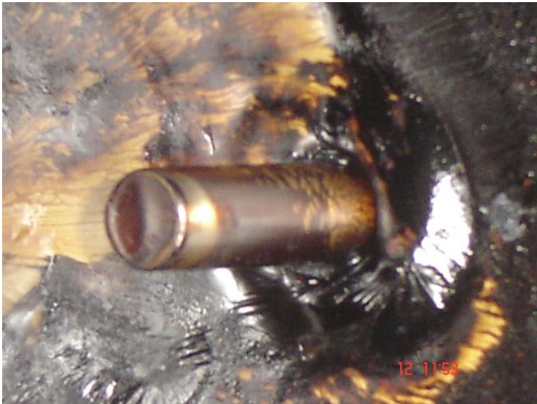
Figura 78. Detalhe da incrustação no poço do sensor de temperatura.
