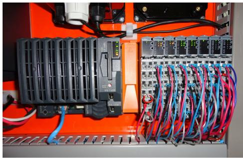
Figura 4.14: Controlador lógico programável B&R modelo CP-X20-1485 .
