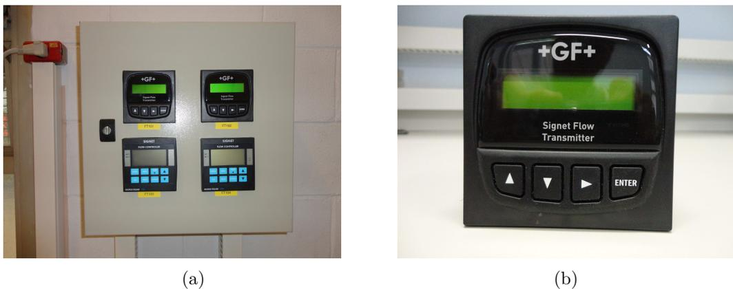
Figura 4.13: Painel auxiliar de instrumentação: (a) cobertura frontal do painel auxiliar; (b) transmissor de vazão (*Signet 8550-1*) em detalhe.
