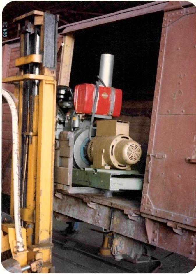
Figura 3.12 - Montagem do grupo gerador no CA.
