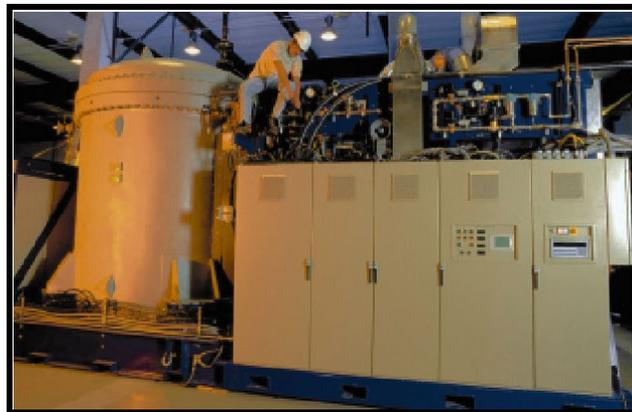
**Figura 2.3 – Unidade estacionária SOFC de 220 kW da *Siemens*. Fonte: (Siemens, 2007).**
