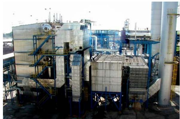
**Figura 2.6** Caldeira de 2 tubulões – Usina Unialcool, 120 t/h, 4,2 MPa e 480°C.
