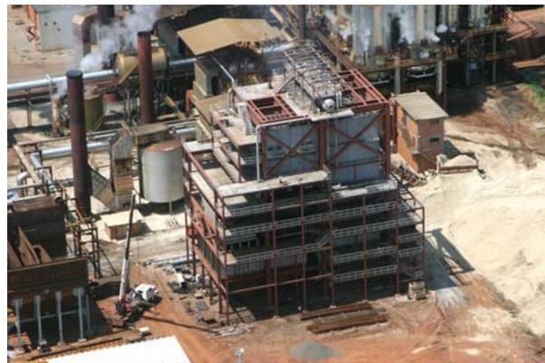
**Figura 2.8** Usina Santa Terezinha – Tapejara PR, AMD 300t/h; 6,5MPa e 480°C.
