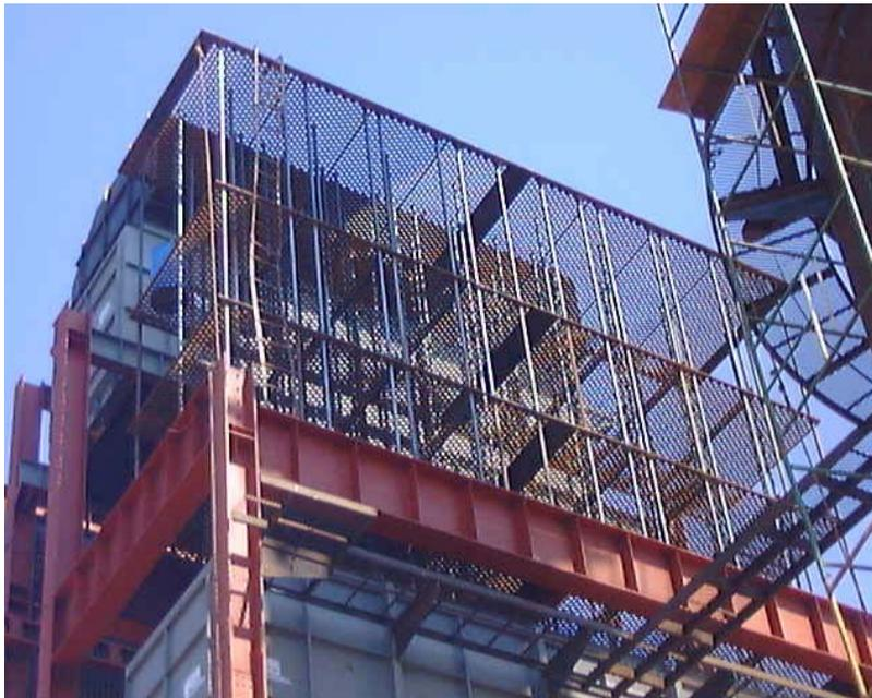
**Figura 4.11** Pré-aquecedor de ar industrial das caldeiras de bagaço de cana
