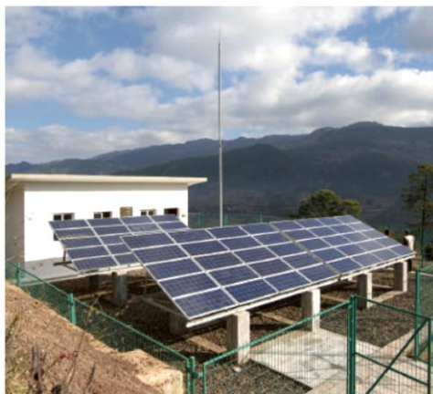
Figura 2.10: Sistema solar-Diesel na província chinesa de Yunnan
