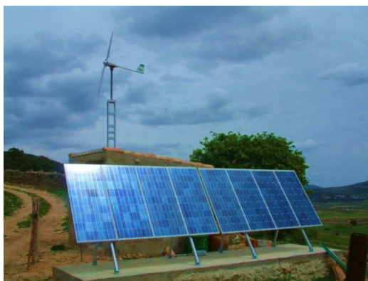
Figura 2.5: Sistema híbrido eólico- fotovoltaico na região de San Juan na Espanha
