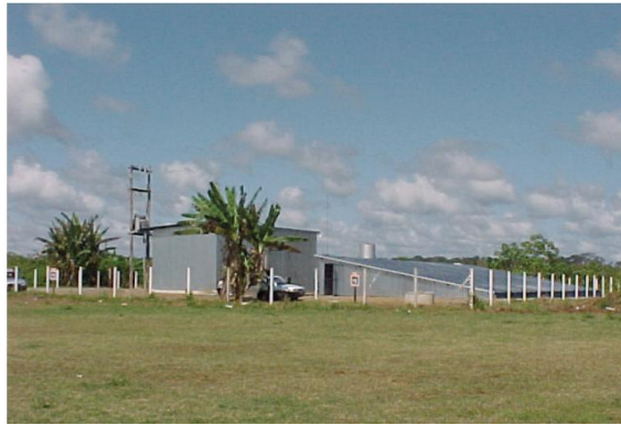
Figura 2.12: Sistema fotovoltaico-Diesel em Araras- RO
