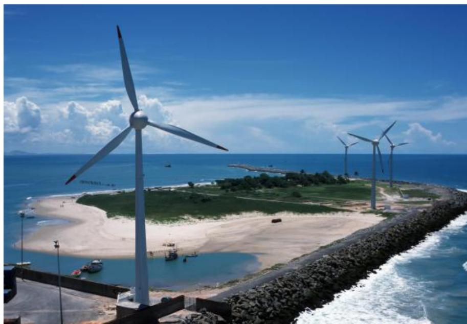
Figura 1 – Em destaque, aerogeradores de 600 kW pertencentes à Central Eólica Mucuripe (Fortaleza - CE). Fonte: WOBEN (2003) apud ANEEL (2005).
