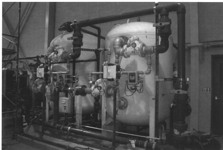
Figura 2. 14. Sistema abrandador de água duplo
