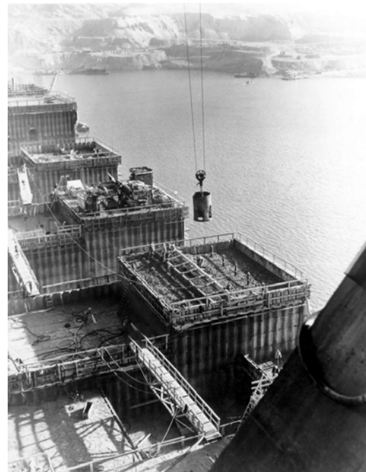
Construção de Grand Coulee. Novembro, 1939.
