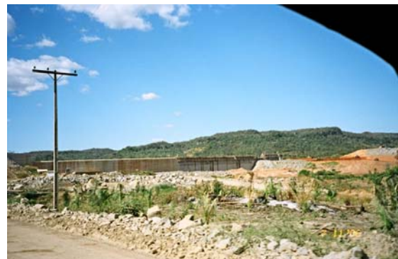
(5.4) Paredão da barragem da PCH Mosquitão
