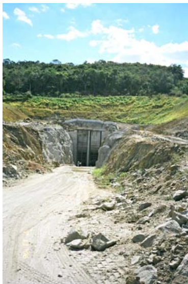
(5.5) Canal de adução da PCH Mosquitão
