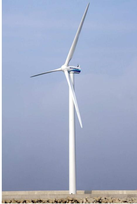
Figura 2.2: Turbina eólica cujas pás são fabricadas de materiais compósitos.
