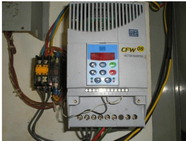
**Figura 6.4: Inversor de frequência**
