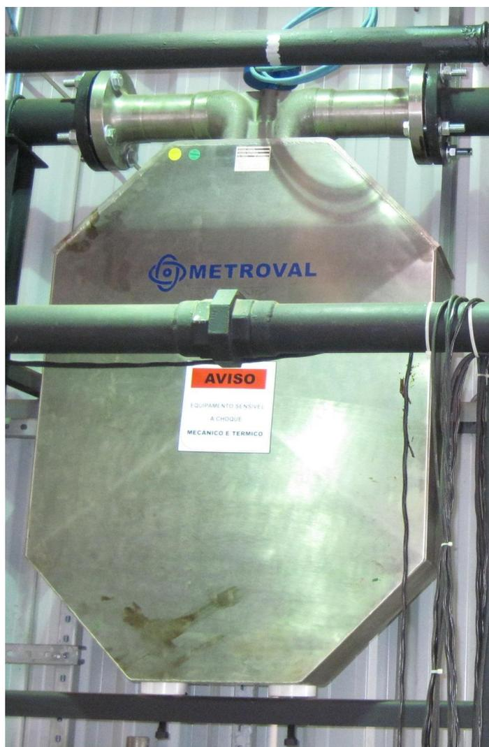
Figura 3.6: Medidor mássico de vazão tipo coriolis utilizado na linha de diesel.
