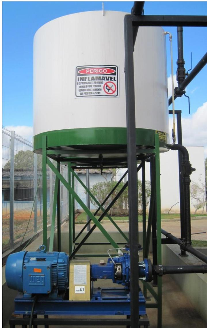
Figura 3.5: Bomba centrífuga utilizada no escoamento do óleo diesel. Acima, reservatório de óleo diesel.
