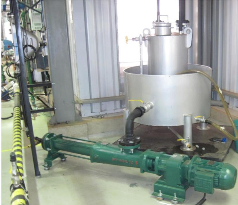
Figura 3.4: Tanque para solução estoque de aditivo redutor de atrito em diesel e bomba helicoidal para injeção da solução estoque de aditivo na linha de diesel. No canto superior esquerdo pode-se observar o medidor de vazão mássica da solução estoque.
