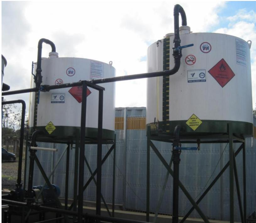
Figura 3.3: Reservatórios de óleo diesel (esquerda) e descarte (direita) que se localizam na parte externa ao LabPetro.
