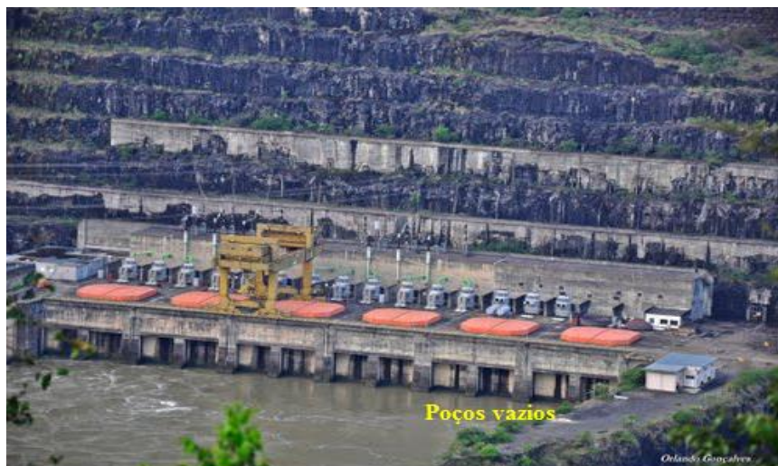
Fonte: Google Earth – Panoramio, acesso em 11/01/2014 Figura 2.14: UHE Governador Bento Munhoz
