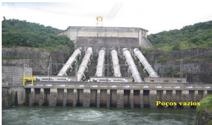
Fonte: Google Earth – Panoramio, acesso em 18/01/2014 Figura 2.23: Vista do canal de fuga da UHE Salto Santiago
