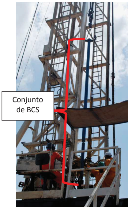
Figura 5 – Instalação de conjunto BCS.
