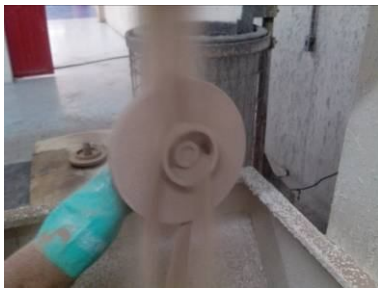
(j) aplicação revestimento
