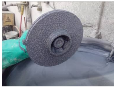
(k) aplicação revestimento
