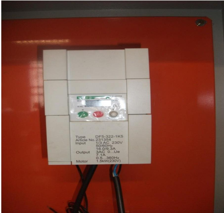
Figura 3.6 Inversor de frequência para controle da bomba.
