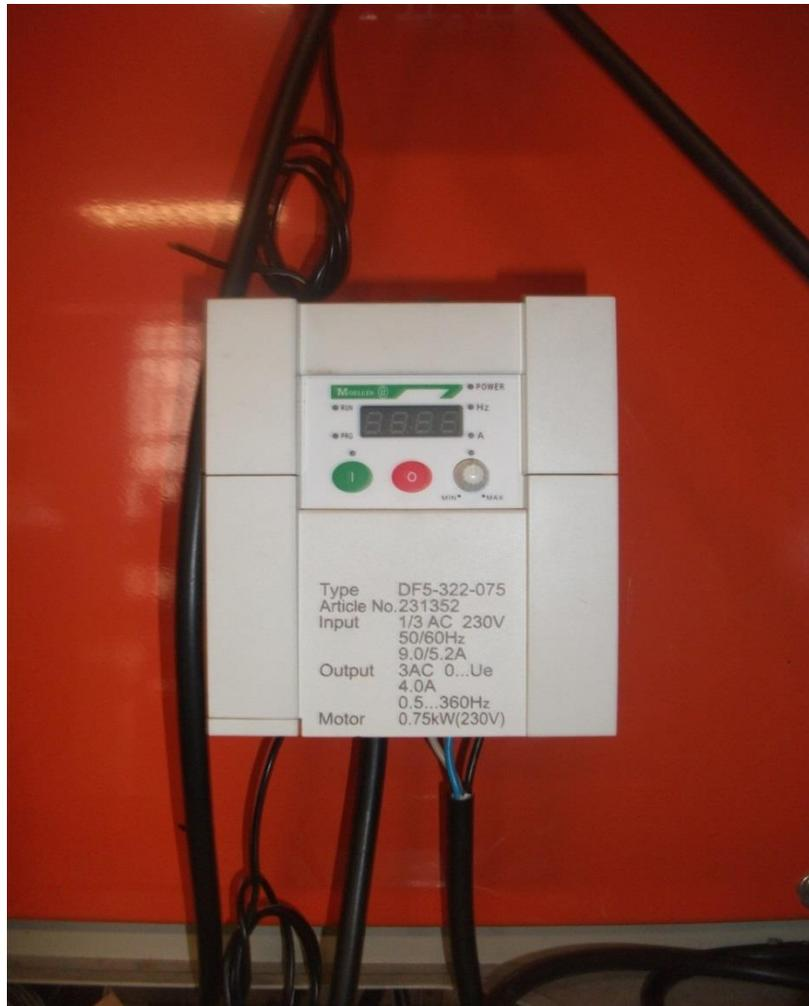
Figura 3.8 Inversor de frequência para controle do fancoil.
