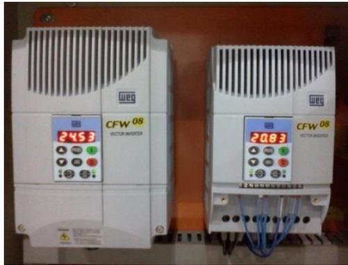
Figura E. 4 – Foto dos inversores de frequência para as bombas (entrada e saída).
