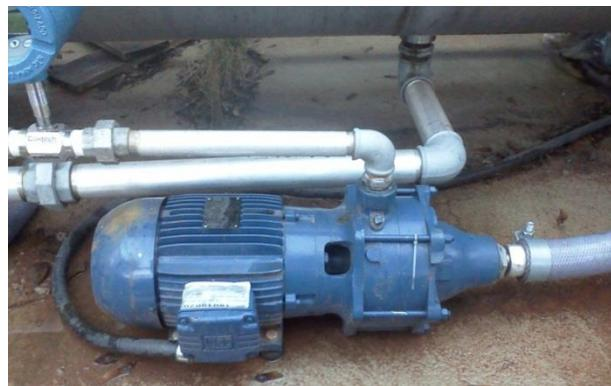
Figura E. 3 – Bomba centrífuga instalada na linha de saída de líquido do separador.
