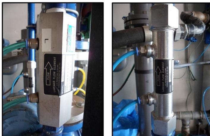
Figura E. 8 – Elementos de escoamento laminar.
