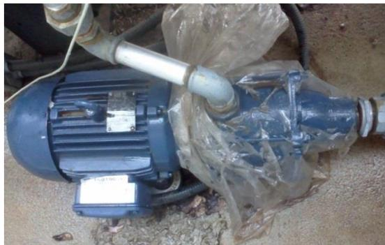
Figura E. 2 – Bomba centrífuga instalada na linha de entrada de líquido do separador.
