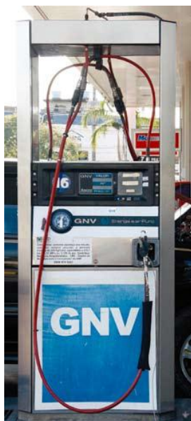
Figura 2.11- Dispenser para abastecimento de GNV
