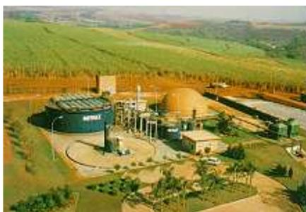
**Figura 25: Vista aérea da planta de digestão anaeróbia da vinhaça na Destilaria São João**
