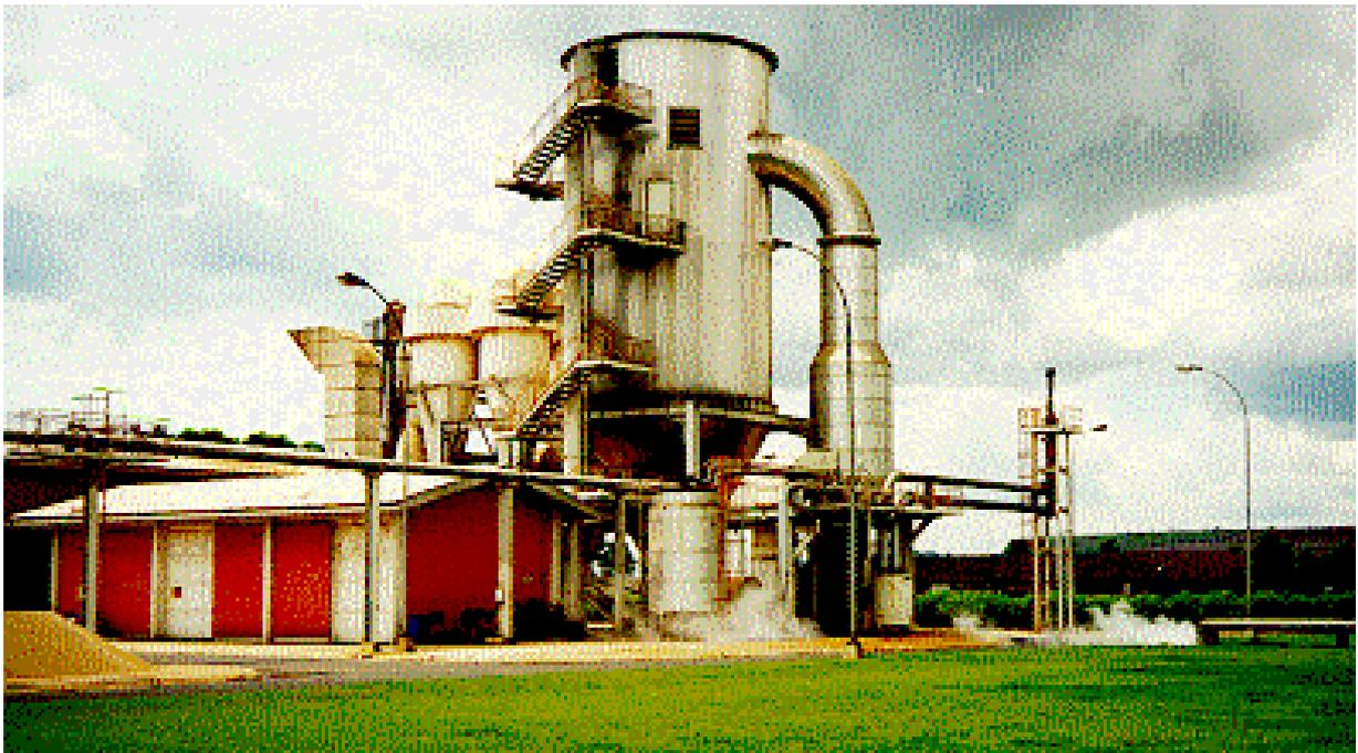
**Figura 28: Queimador para secagem de levedura utilizando o biogás na Usina São Martinho**
