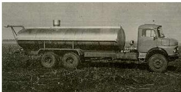
**Figura 9: Caminhão-tanque para a distribuição de vinhaça**
