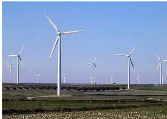
figura 2.2: Parque Eólico Praias de Parajuru, Ceará – 19 aerogeradores totalizando 28,8 MW.
