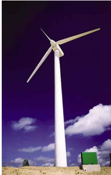
figura 2.1: Segunda turbina eólica de Fernando de Noronha (225 kW).
