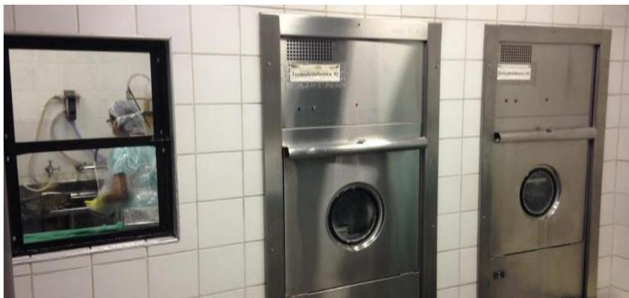
Figura 3: Expurgo - Área de limpeza na janela e termodesinfectoras, que separam a área de limpeza e a de secagem (Fonte: Autor).
