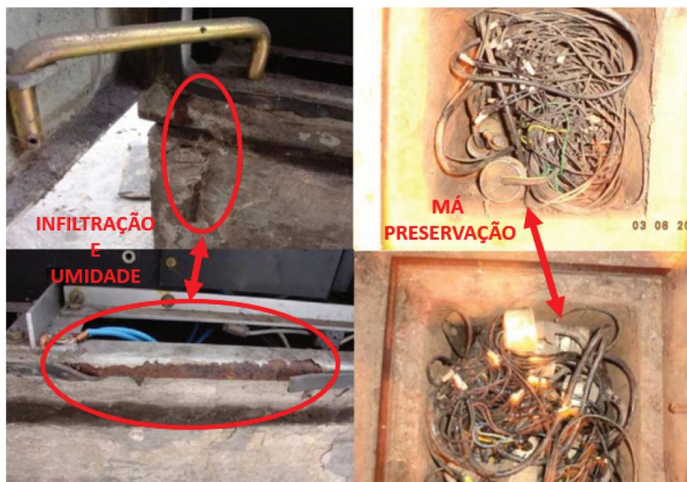
Figura 2.7 – Cabos de controle e comunicação de sistemas semafóricos em condições de má preservação (CET, 2013b).
