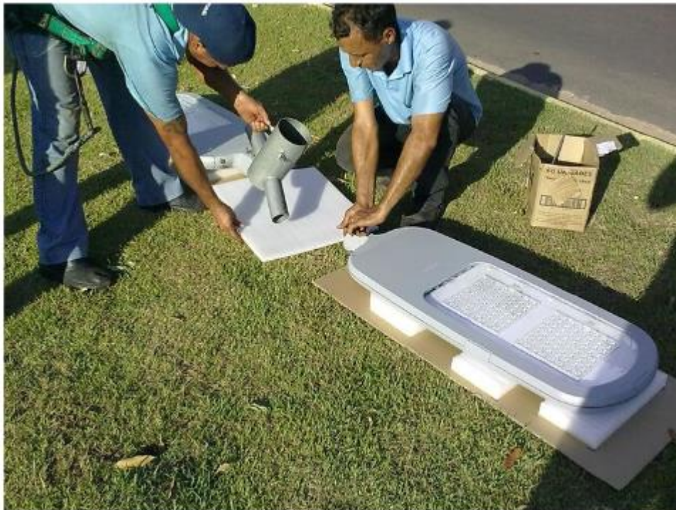
Figura 2.12 – Instalação das luminárias LED com a utilização de suporte duplo [14]
