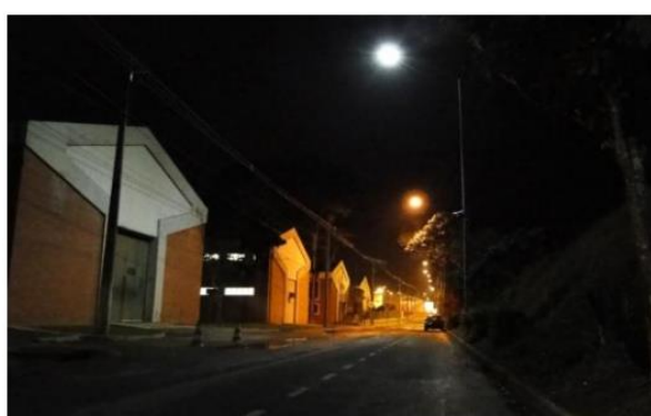
Figura 2.9 – Comparação entre luminária LED e Vapor de Sódio [12]
