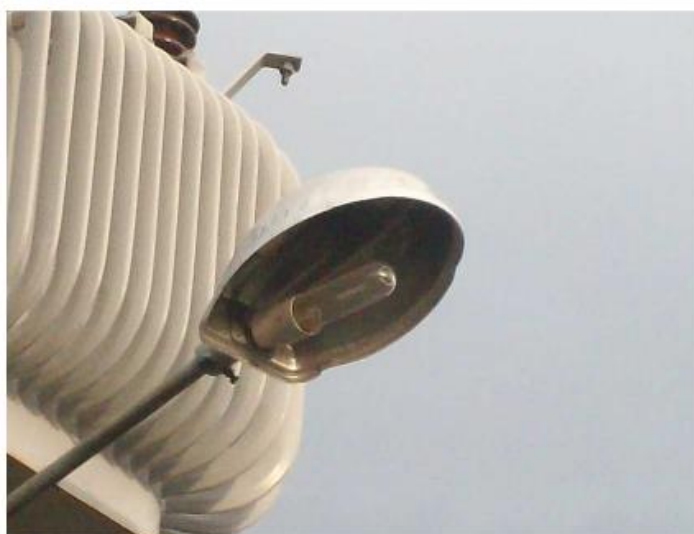
Figura 2.29 – Luminária com a carcaça tipo Aberta [34].
