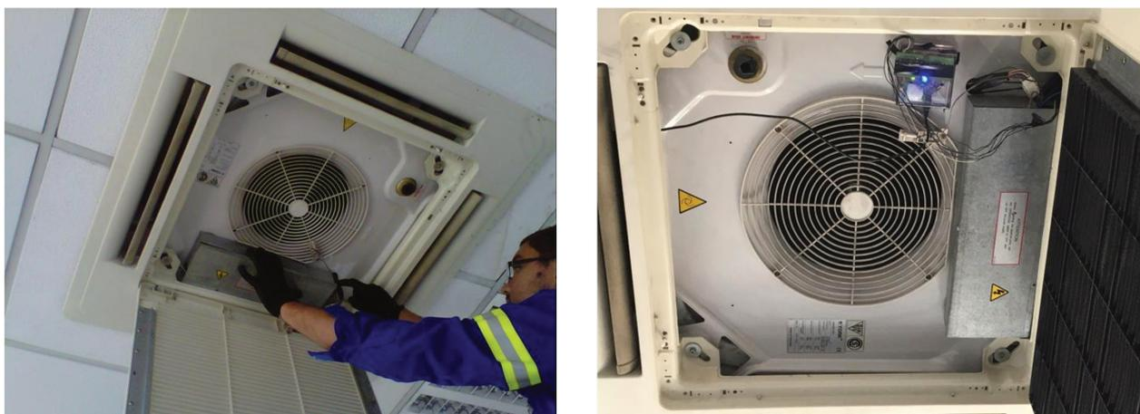
Figura 36. Instalação do módulo atuador no interior do cassete de ar condicionado.
