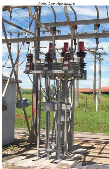
*Fig. 2.10 - Disjuntor com câmara de extinção a gás  $SF_6$ .*
