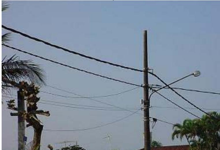
Fig. 2.3 – Rede aérea com cabo isolado.
