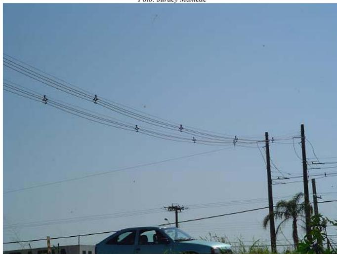
Fig 2.4 – Rede aérea compacta com cabo protegido.
