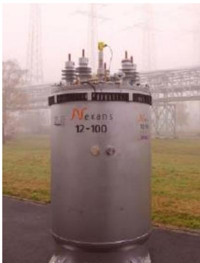
**Figura 3.5: LCESR 12kV/2MVA instalado em Lancashire, Reino Unido [19].**
