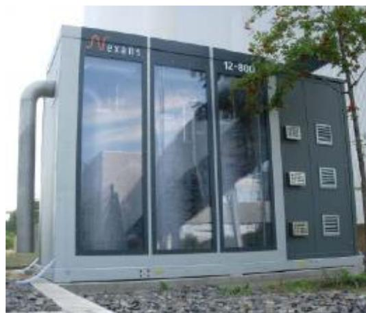
**Figura 3.6: LCESR 12kV/16MVA instalado em Boxberg, Alemanha [20].**
