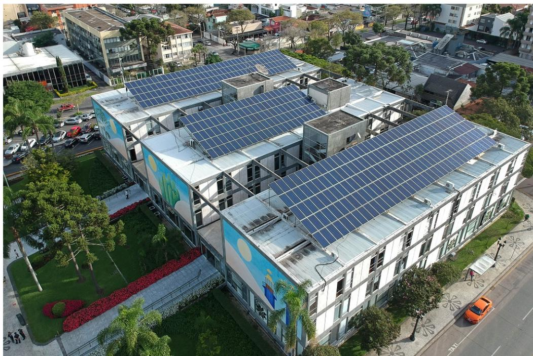
Figura 1.3: Sistema fotovoltaico instalado na Prefeitura de Curitiba [2].
