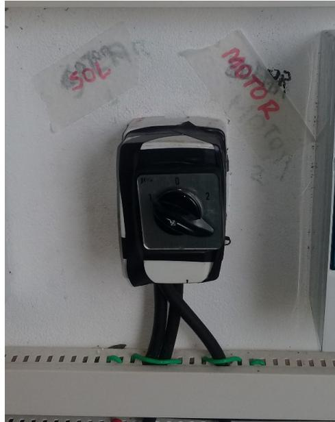
Figura 4.12: Chave de transferência manual para escolha do sistema de geração solar-diesel.
