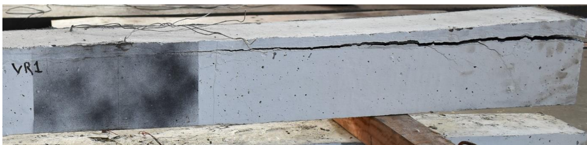
Figura 40 – falha por descolamento da camada de reforço
