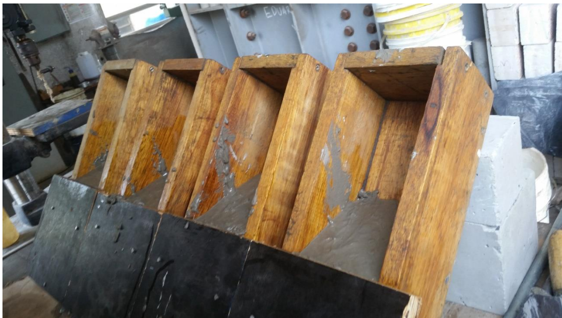
Figura 20 – moldagem dos corpos de prova do slant shear test
